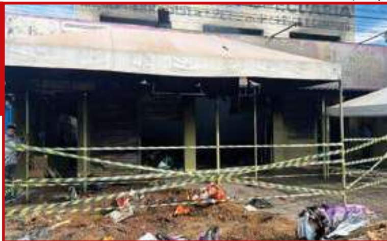
Loja destruída por incêndio
